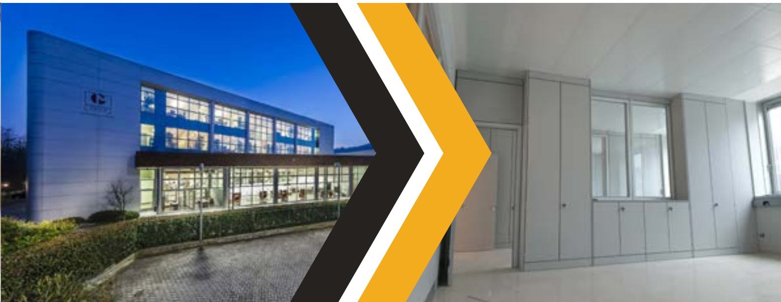
Uffici per industria | Bologna - Impianto radiante a soffitto con quadrotti open
